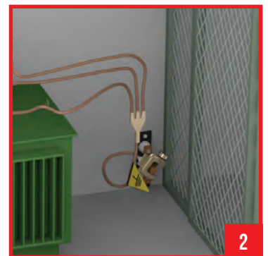
SYSTÈME DE MISE À LA TERRE
